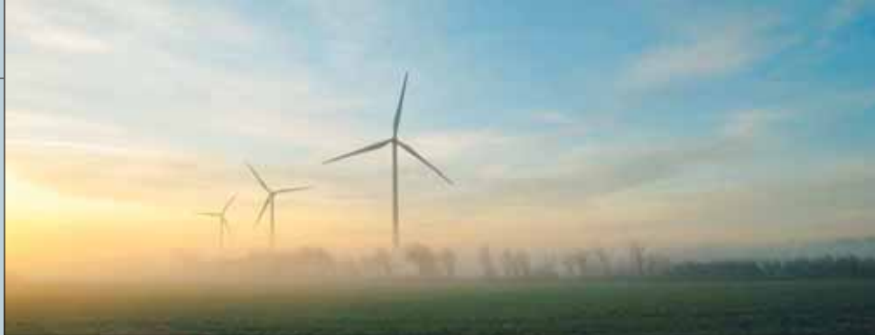
Den politiska inställningen och de europeiska klimatmålen gör att vindkraften är mer intressant än någonsin. Foto: Varberg Energi
